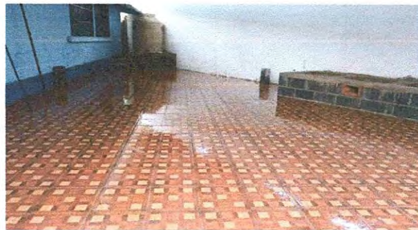
Foto 2: Sustitución de piso de concreto a piso ceramico
