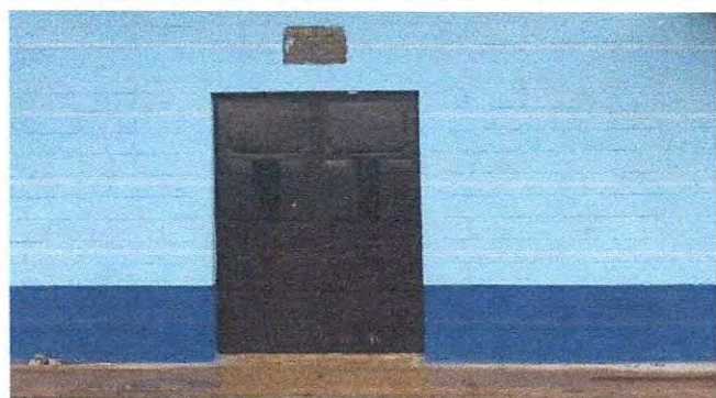
Foto 3: Sustitucion de porton de metal
