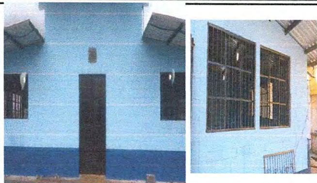
Foto 1: Sustitución de 4 balcones de la parte de enfrente del establecimiento.
