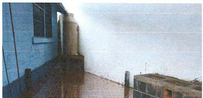
Foto 3: Repello, cernido en paredes de la cocina, en el interior y exterior
